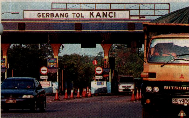
GERBANG TOL KANCI. PROYEK TOL ANDALAN BAKRIE
